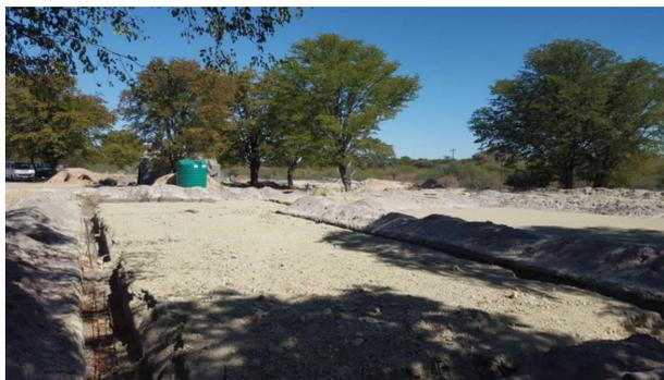
*Aushub für das Fundament des ersten geplanten Gebäudes.*
